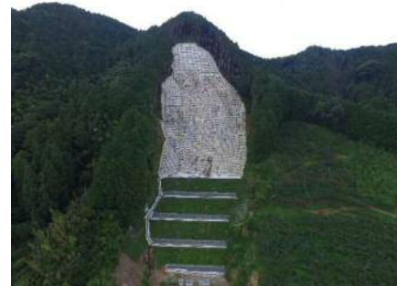
大隅地域道路災害防除工事
