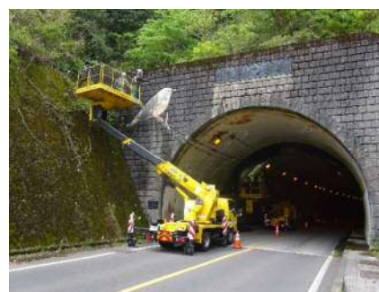
トンネル点検/補修作業
